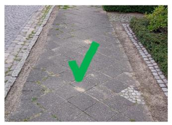
Das regelmäßige Reinigen trägt zu einer verminderten Ablagerung und Keimung von durch Wind eingetragenen Samen von Pflanzen und insbesondere Gräsern in den Fugen der Pflasterungen bei und verhindert den großen Aufwand fest verwurzelte Pflanzen aus den Fugen zu entfernen.
